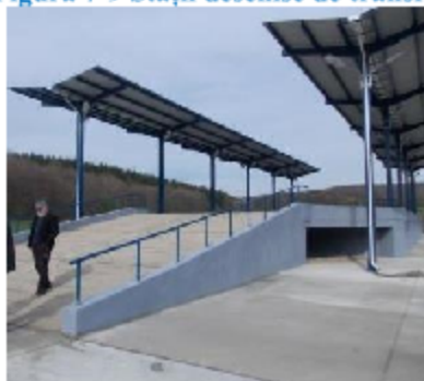
Figura 7-9 Stații deschise de transfer
