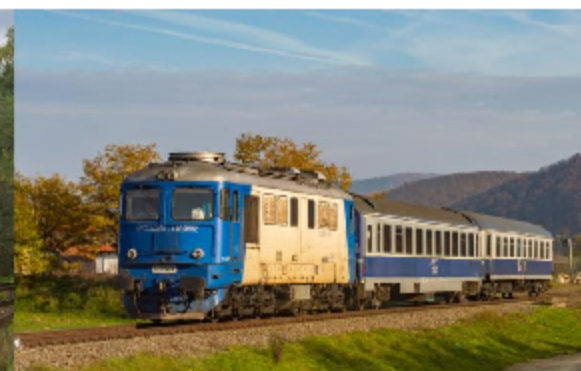
Cale ferată simplă neelectrificată 837 km
